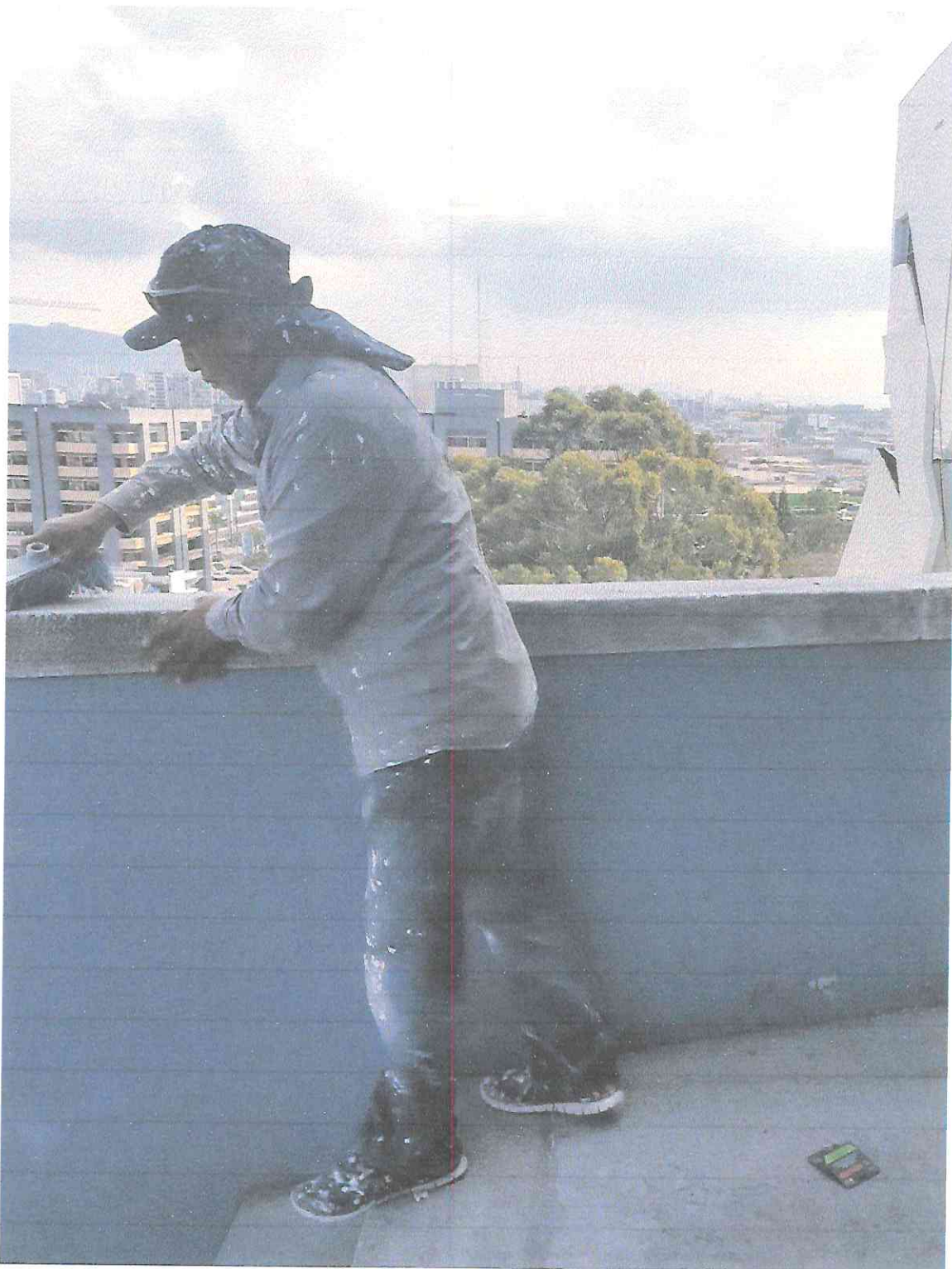
Limpieza y desinfección de teselas y bordillo en segmento B2 de fachada Oriente.
